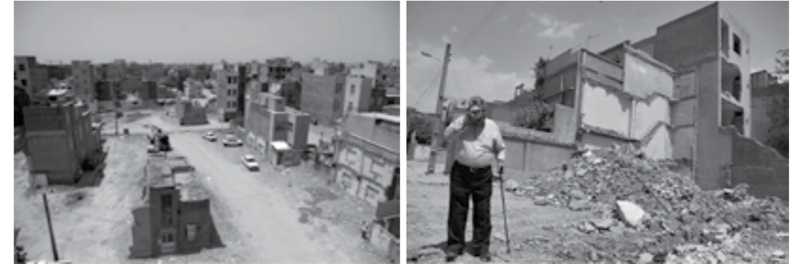
شکل (۲) - تصاویری از تخریب منازل در طرح اتوبان امام علی (حین اجرای طرح)
