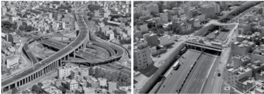
شکل (۳) - تصاویری از اتوبان امام علی (بعد از اجرای طرح)
