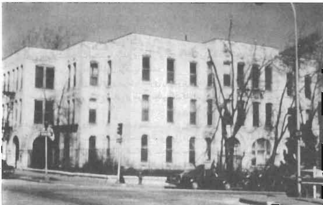
هتل ویرجینیا قبل از بازسازی
