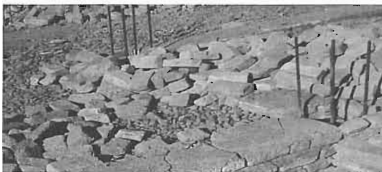
شکل ۱۴. میلگردهای اصلی کلاف قائم به جای آنکه در کلاف افقی مهار شود بر روی خاک قرار گرفته است
