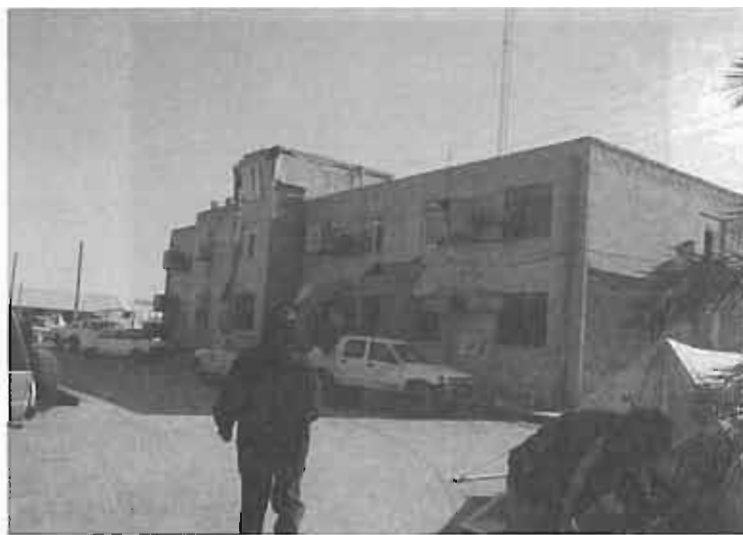
شکل ۱۲. کلاف بندی باعث پایداری و عدم فرو ریختن ساختمان دو طبقه شده است هر چند اشتباهاتی چند در نحوه کلاف بندی و عدم مهار کردن مناسب نما به سازه باعث بروز خرابی هایی شده است.
