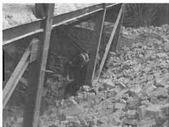
شکل ۱۸. کنده شدن بادبند، اتصال نامناسب بادبند به ستون
