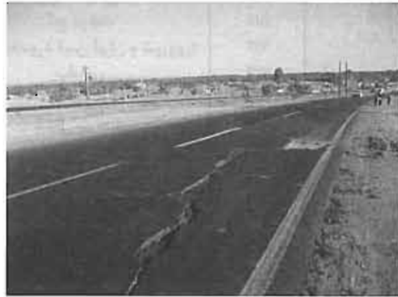
شکل ۱۰. در جستجوهای اولیه اثری از جداسدگی و حرکت زیاد در گسل ملاحظه نگردید و فقط ترک‌های جزئی در سطح زمین و جاده قابل رؤیت می‌باشد.
