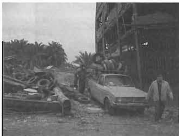
شکل ۱۷. ساختمان اتصال خرچینی به کمک میانقاب‌ها در برابر زلزله پایدار مانده است. تعدادی از میانقاب‌ها در اثر مؤلفه عرضی از صفحه خود به خارج پرت شده‌اند.
