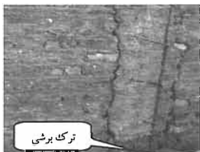
شکل ۱۳. بروز ترک برشی در کلاف قائم در نزدیکی اتصال
