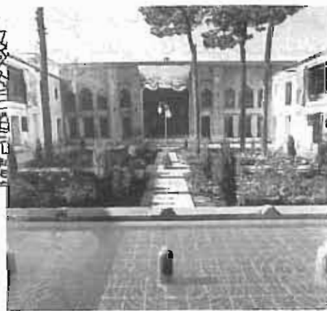
حسینیة ناظم التجار - یزد، خیابان سلمان فارسی، کوی گذرگاه. کاربری قبلی حسینیه. کاربری فعلی فرهنگی. مساحت (عرصه ۸۲۵، اعیان ۱۵۵۰ مترمربع) از این بنا پس از مرمت به عنوان انواع نمایشگاهها و کلاسهای هنری استفاده می شود و ارتباط بسیار خوبی را با شهر و محله ایجاد کرده است.
